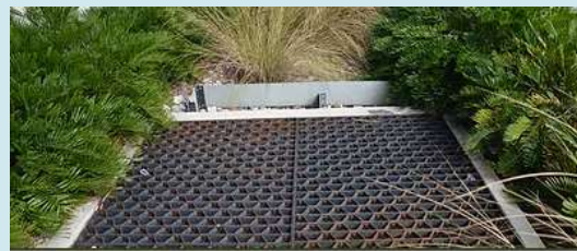
Brother Geenan Way Storm Culvert
